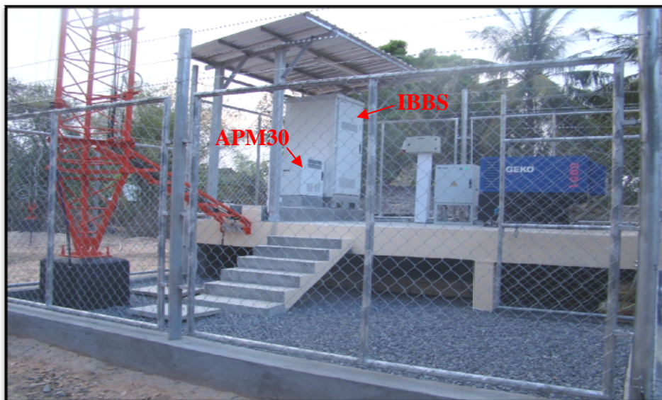
Figure 4.2 : Photo d'un site DBS3900
